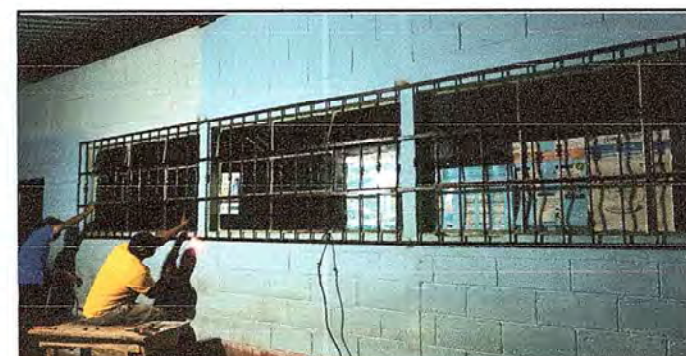
SEGUIMIENTO COLOCACION DE BALCONES
