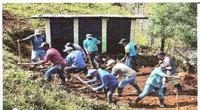
PREDIO DE CONSTRUCCION DE BAÑOS
