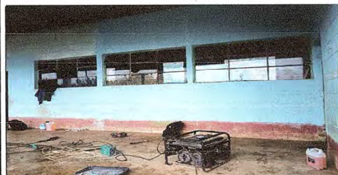
COLOCACION DE BALCONES
