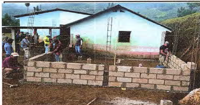
SUSTITUCION DE PAREDES DE COCINA
