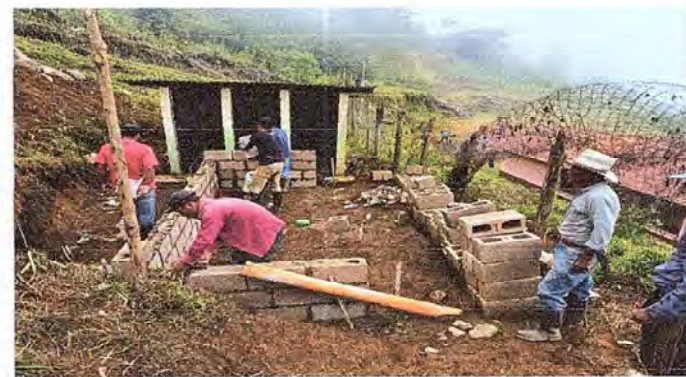
SUSTITUCION DE PAREDES DE BAÑO DE LOS ALUMNOS
